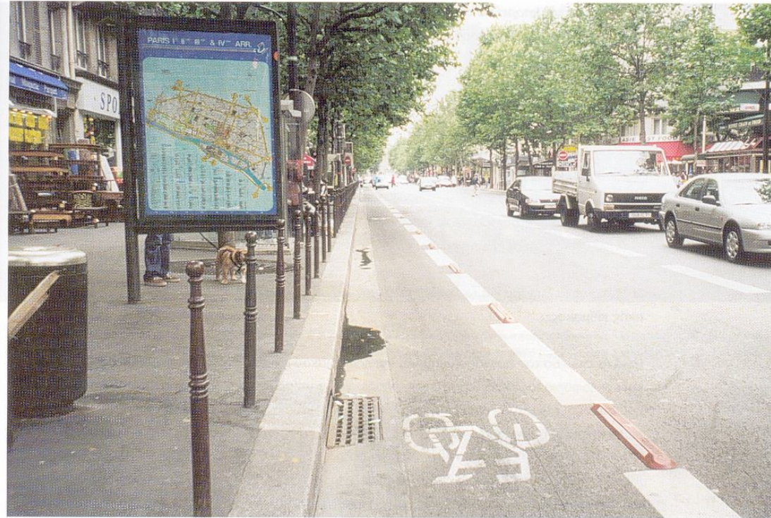
Εικόνα 3: Λωρίδα ποδηλάτου με διαχωριστικά στοιχεία και λευκή διακεκομμένη γραμμή.
