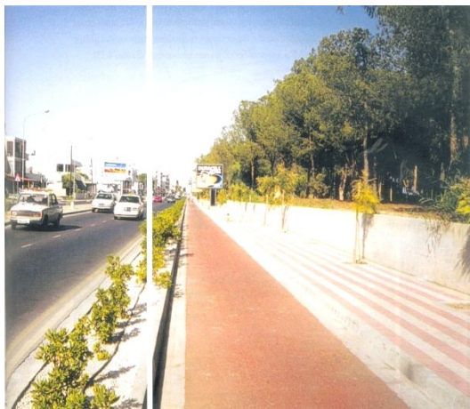
Εικόνα 5: Συνοδευτικός ποδηλατόδρομος με διαχωριστική νησίδα.
