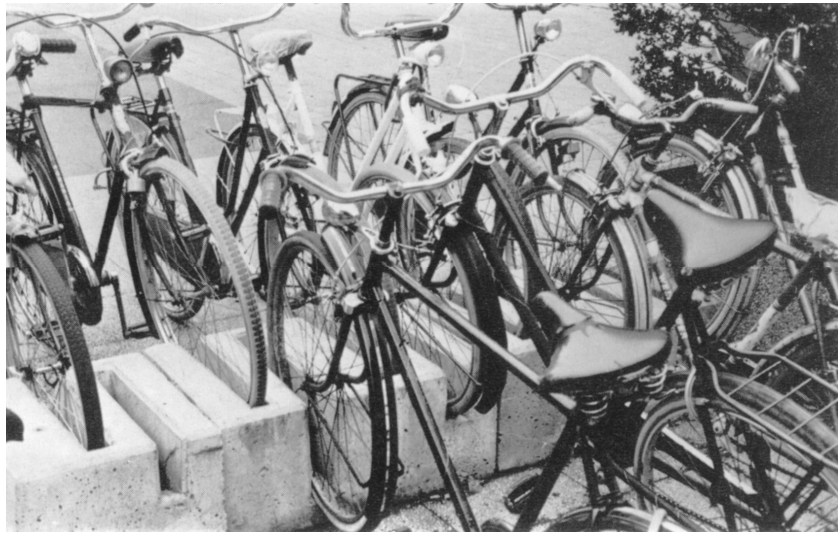
Εικόνα: 39 Προκατασκευασμένα στοιχεία με εγκοπές
