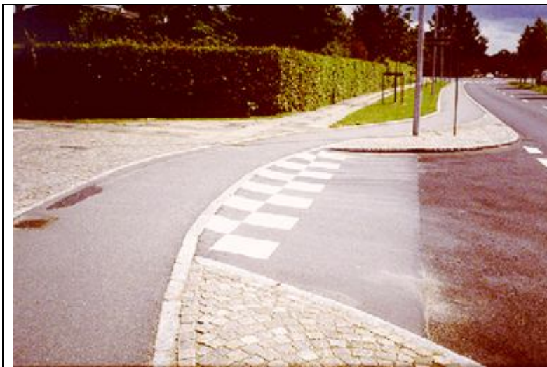
Σχήμα: 15 Ποδηλατόδρομος μη διακοπτόμενος με μετατόπιση του άξονα του στη διάβαση. Με κατάλληλη διαμόρφωση σημαίνεται ότι προτεραιότητα έχουν οι πεζοί και οι ποδηλάτες.
