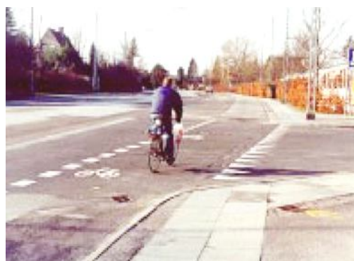
Εικόνα: 25 Διάβαση ποδηλάτου. Δεξιά δεν υπάρχει η διακεκομμένη γραμμή λόγω της γειτνίασης με την διαγράμμιση της διάβασης των πεζών.
